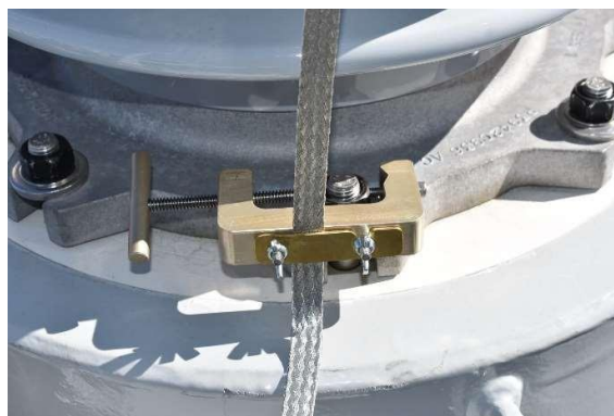
Подключение к заземляющей струбцине
