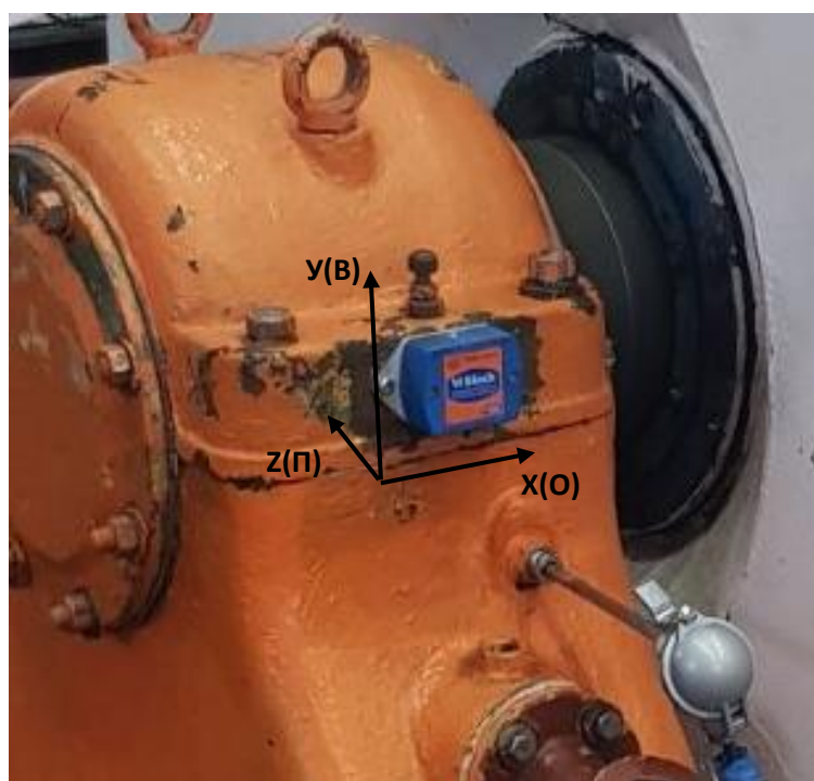
Рис. 4.2. Расположение ViBlock на корпусе подшипника скольжения электродвигателя и ориентация по осям.
