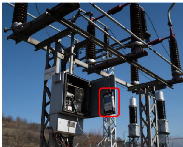
DIS-H смонтированный на шкаф управления разъединителя
