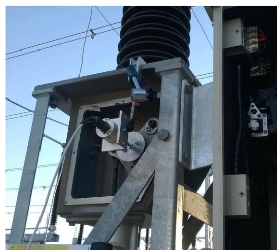
Рисунок 2: Цифровой датчик угловых перемещений, смонтированный на элегазовый выключатель ABB LTB 245 кВ
