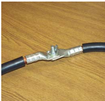
Рисунок В.3 - Последовательное соединение кабелей
