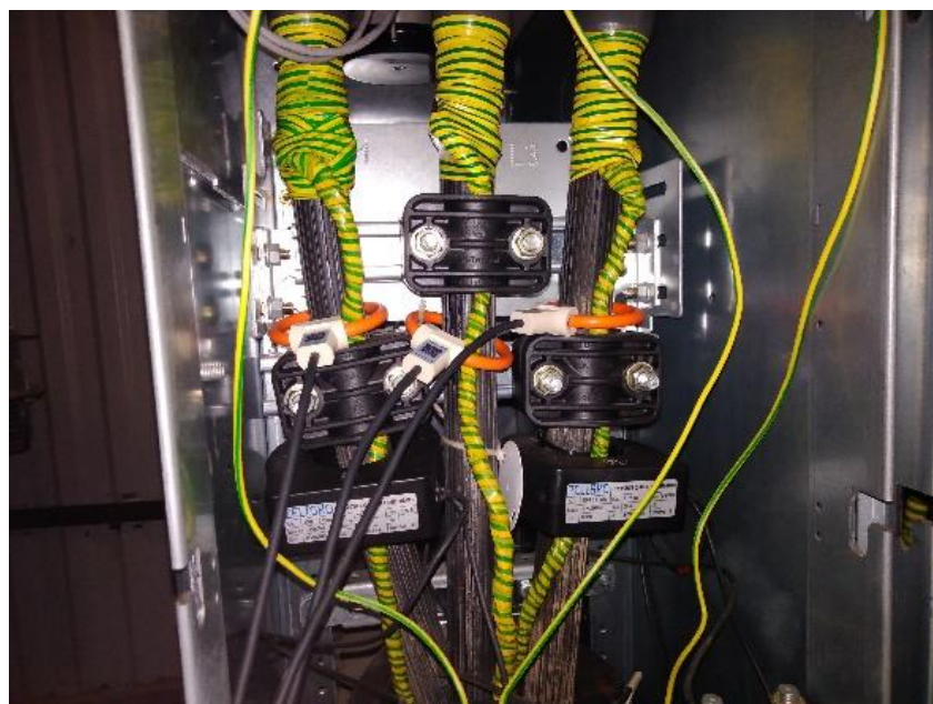
Рисунок 2.3 – Пример установки ДТ в ячейке КРУ
